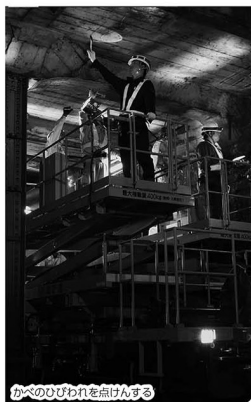
かべのひびわれを点検する
